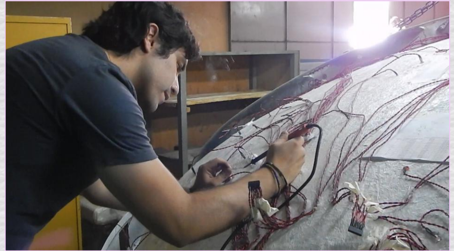
Figura 6: Cableado interno de la electrónica del Planetario.
